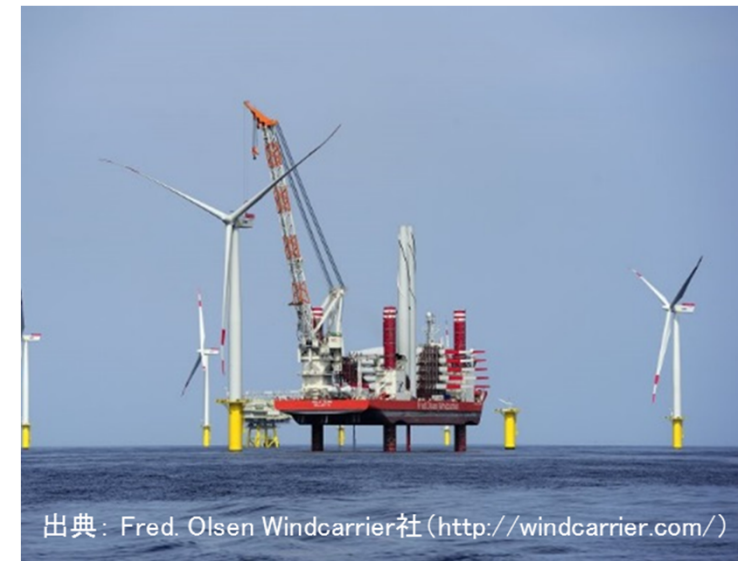
洋上風力発電設備の海上施工の状況
