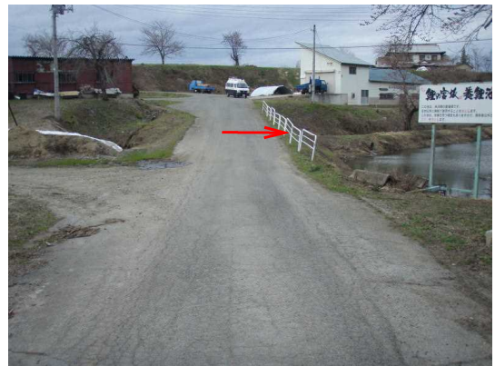
【事故現場の状況】
