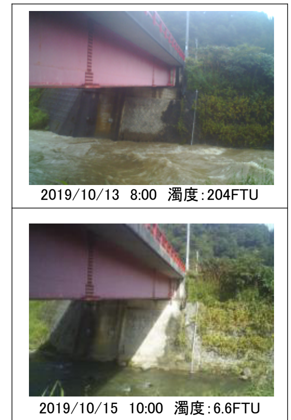
図8 自動撮影カメラで撮影された写真(台風19号通過後)
