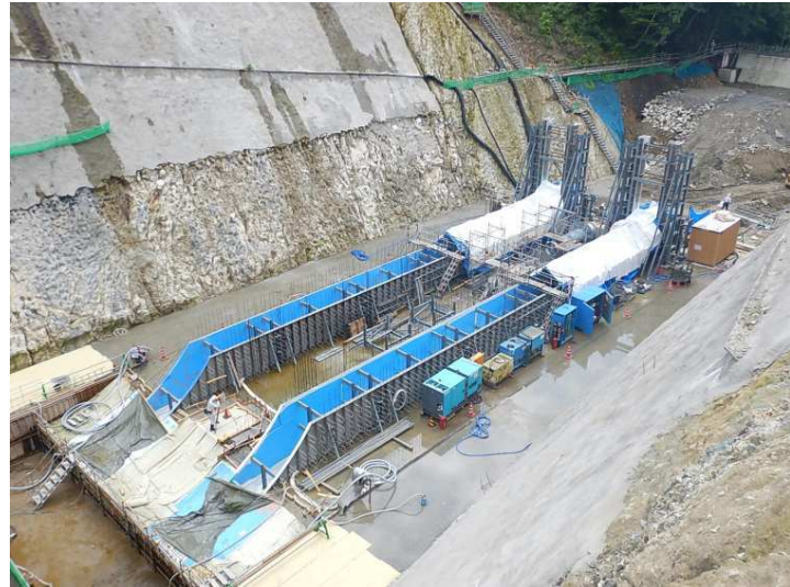
放流設備設置(2門)
