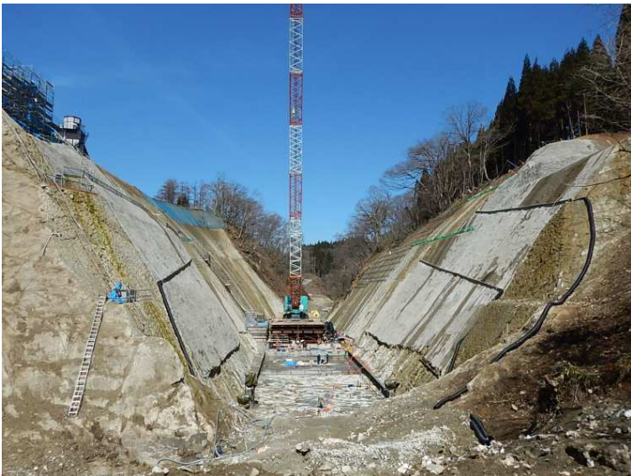
堤体打設開始(河床)
