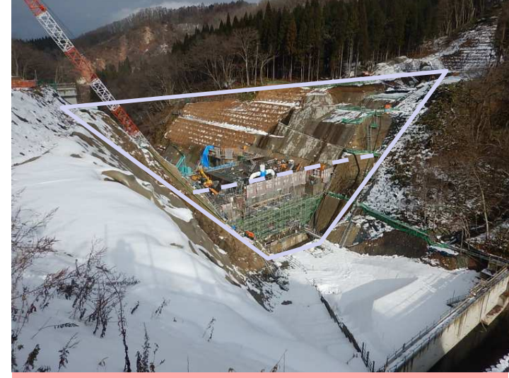
工事進行状況(H29. 12月)
