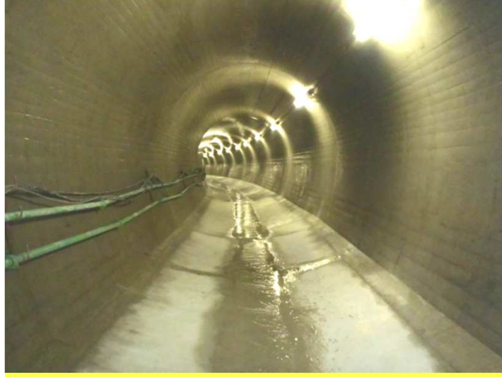
仮排水路(トンネル)
