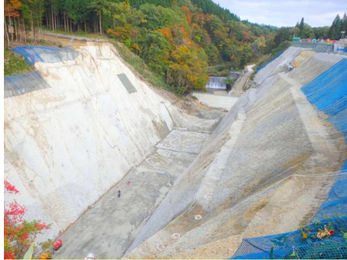
ダム堤体掘削工事
