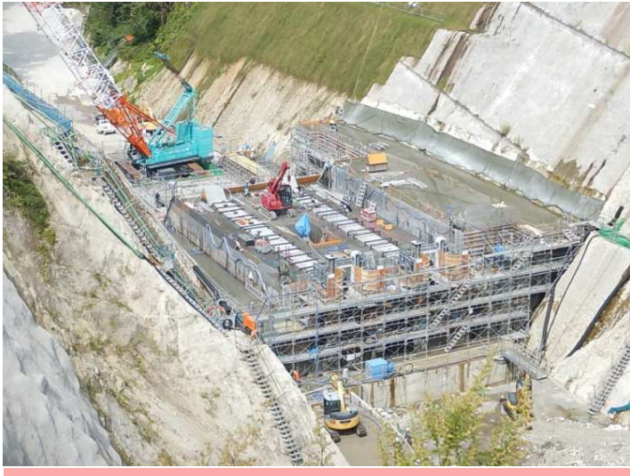
ダム堤体コンクリート打設
