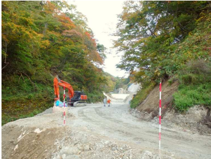
ダム工事用道路造成
