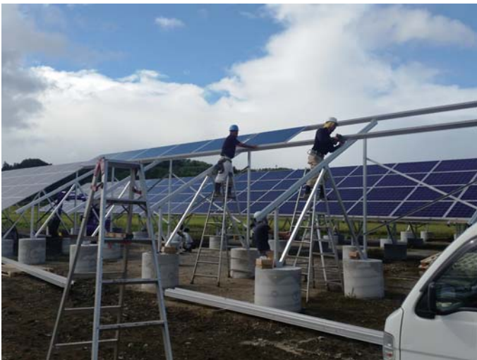
太陽光設備用の架台組立と太陽光パネルの設置工事
