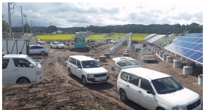
川西太陽光発電設備工事 全体風景
