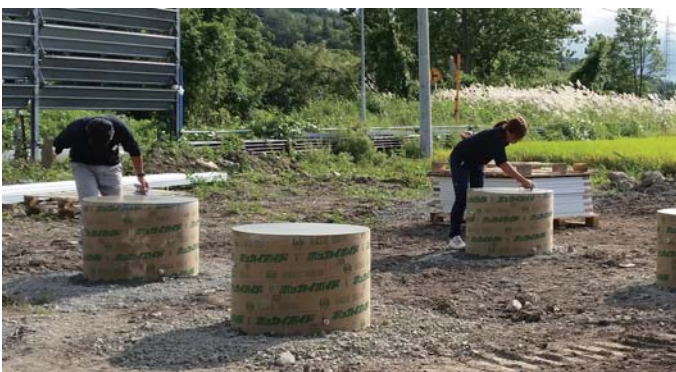
太陽光発電設備の架台 基礎工事の風景
