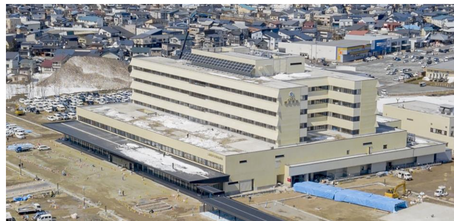
新庄病院 建設状況 (R5.3.20撮影)
