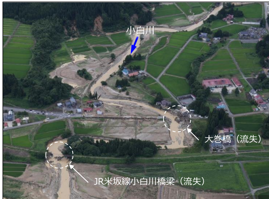
令和4年8月に発生した浸水被害の状況（飯豊町小白川）
