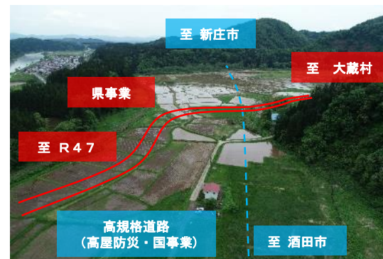
主要地方道戸沢大蔵線（古口）
