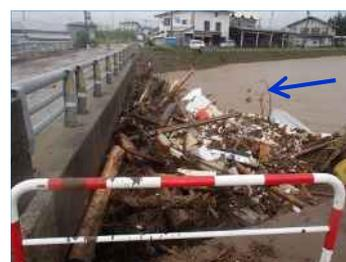
写真2. 吉野川 流木等の堰上げ(吉野橋)
